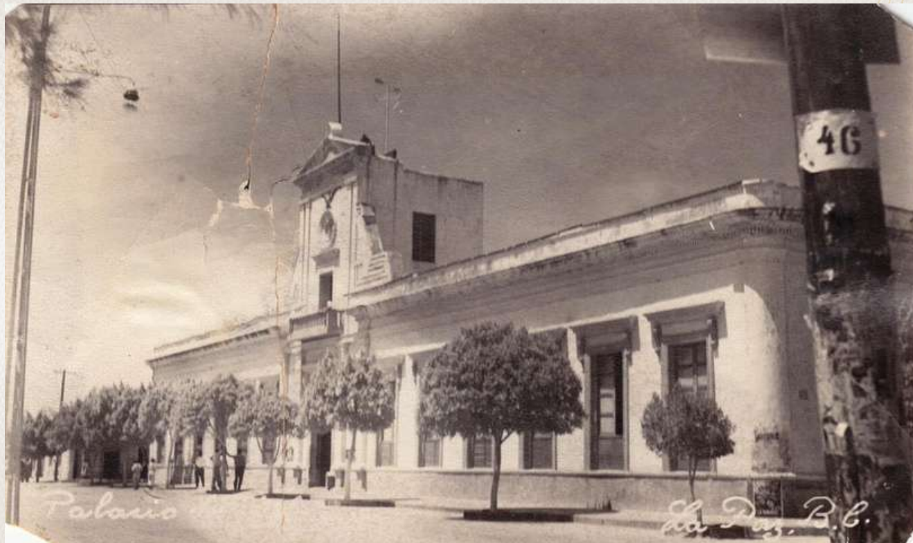
* Vista de la antigua Casa de Gobierno desde la antigua calle Ayuntamiento.
